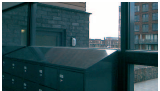
Een schuine bovenkant zorgt dat rommel niet op de brievenbussen blijft liggen
