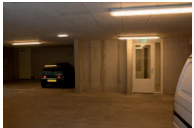
Hier is onvoldoende zicht op de naast de deur gelegen parkeerplaatsen
