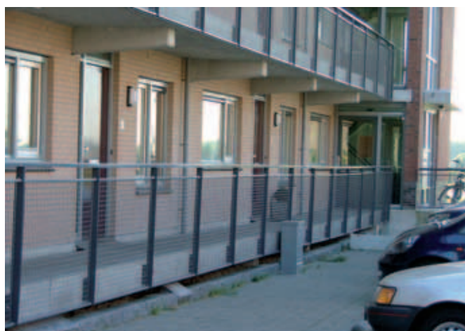
Bij een galerij op de begane grond dienen de deuren naar de centrale ruimte conform G4 uitgevoerd te worden
