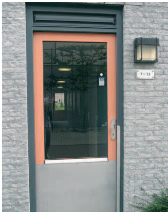
Elke toegangsdeur is verlicht
