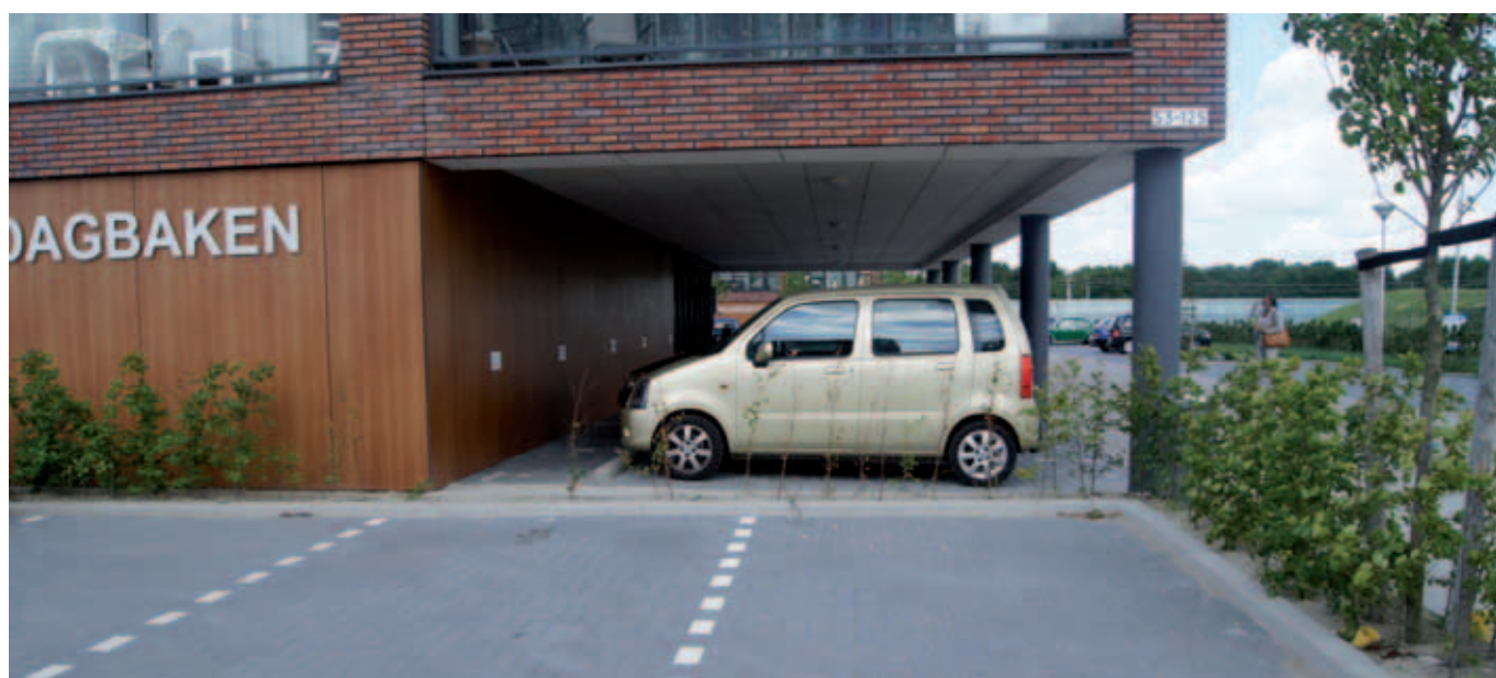
Parkeren in de plint van een woongebouw wordt steeds vaker toegepast. Ook hierop dient zicht te zijn vanuit minimaal twee woningen.
