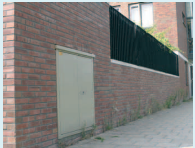
Voorbeeld van ingebouwde kast van nutsbedrijf
