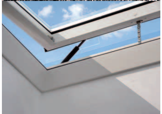
Inmiddels zijn er goedgekeurde lichtkoepels die aan de PKVW-eisen voldoen
