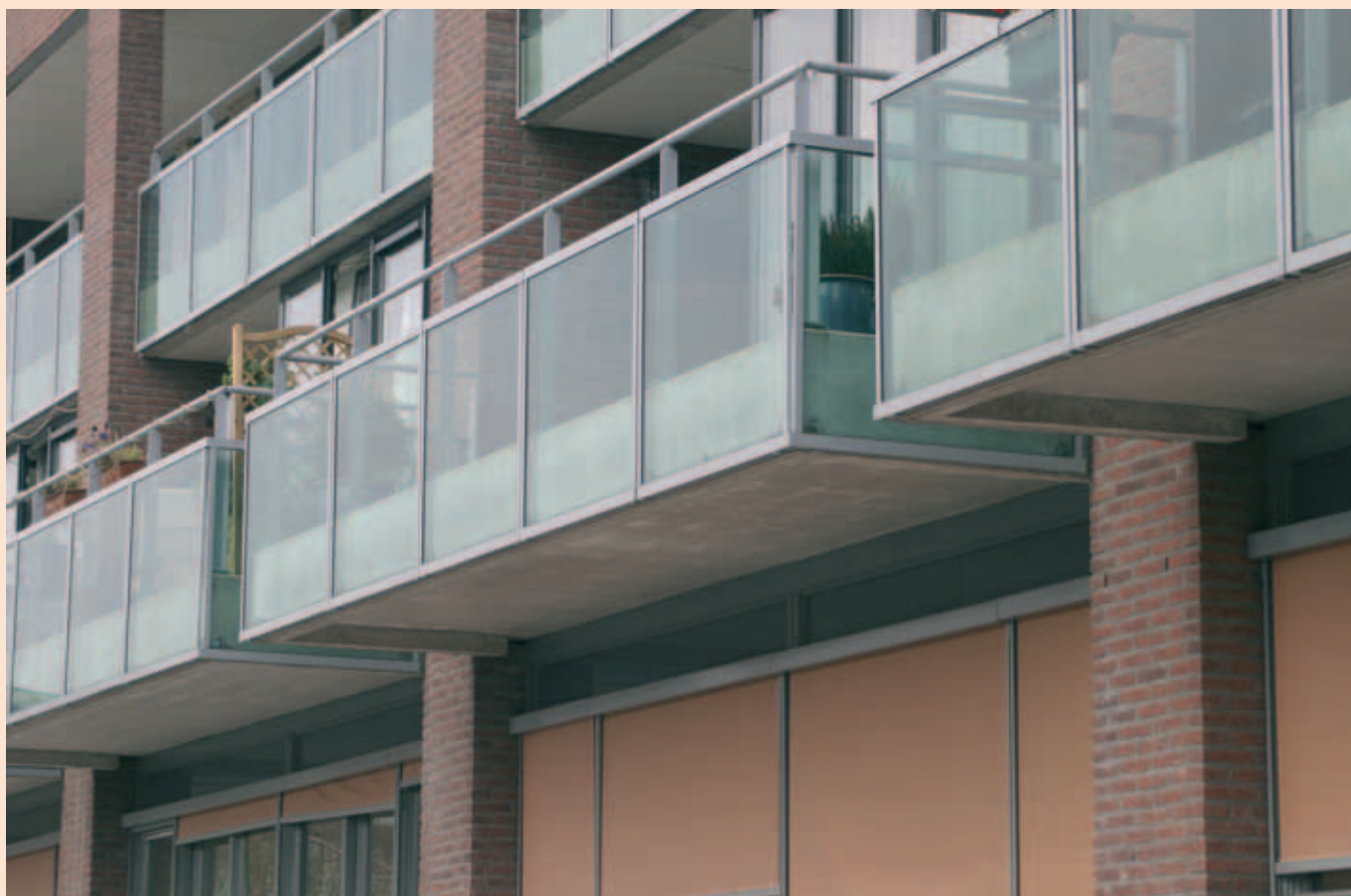
Opklimmen niet mogelijk. Onder borstwering/glasplaat zijn geen aangrijppunten
