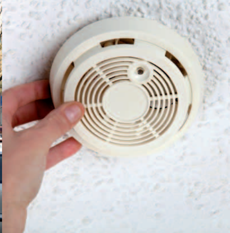
Een rookmelder binnen het PKVW is verplicht
