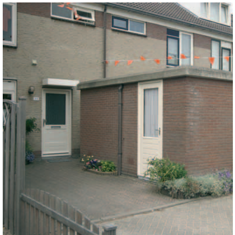
Fout: tussenuimte tussen berging en gevel (nis) zorgt ervoor dat mensen zich kunnen verstoppen
