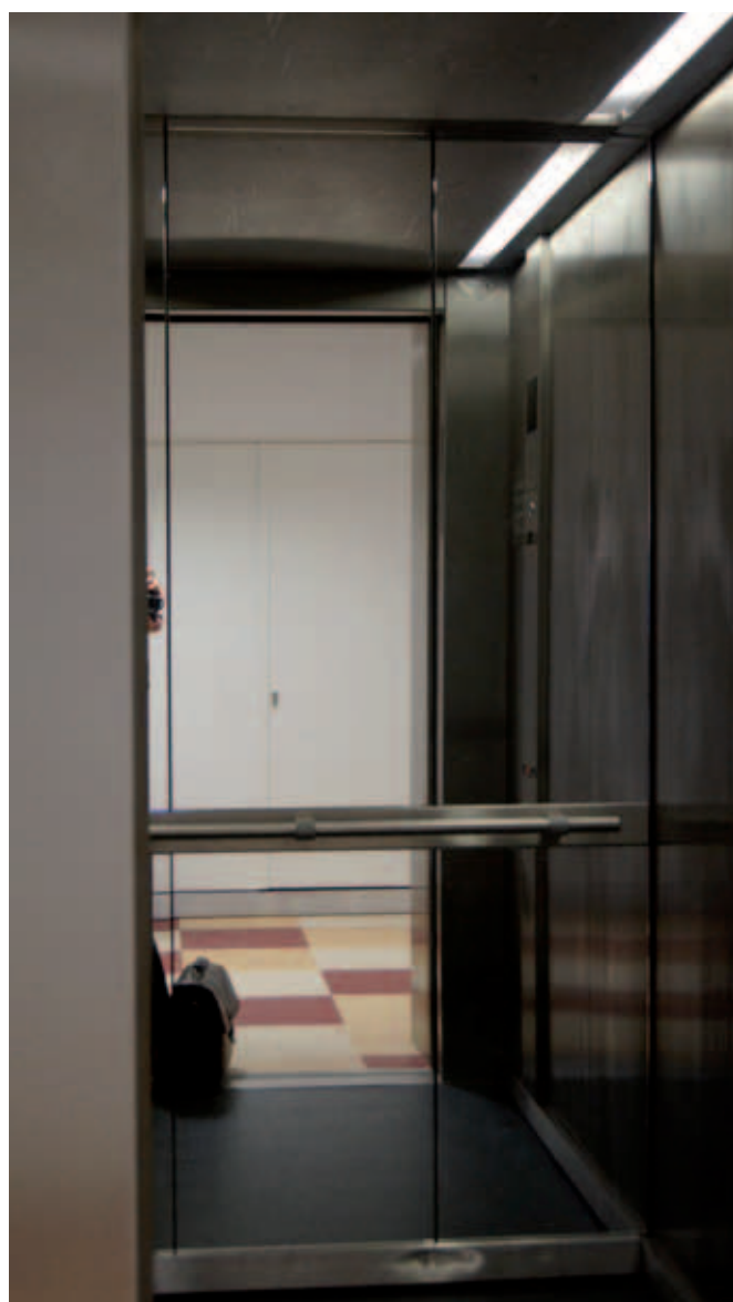
Een spiegel op de achterwand van een lift geeft een ruimtelijk effect en zorgt voor overzicht, ook voor rolstoelgebruikers. Een spiegel tot op de grond is echter niet aan te bevelen in verband met beschadigen.
