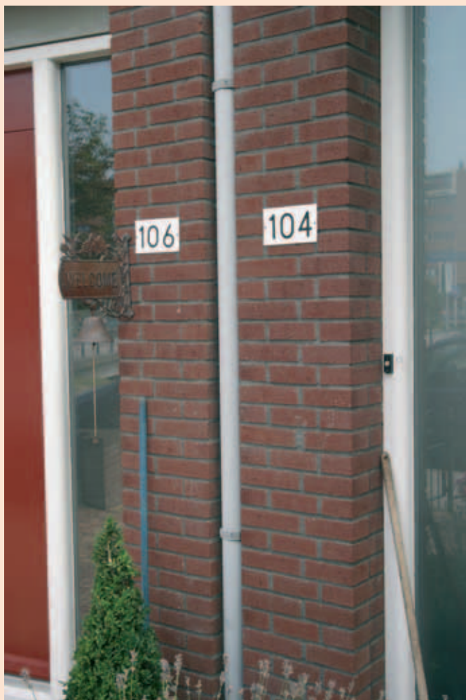
Regenpijp weggewerkt in de muur voorkomt opklimming
