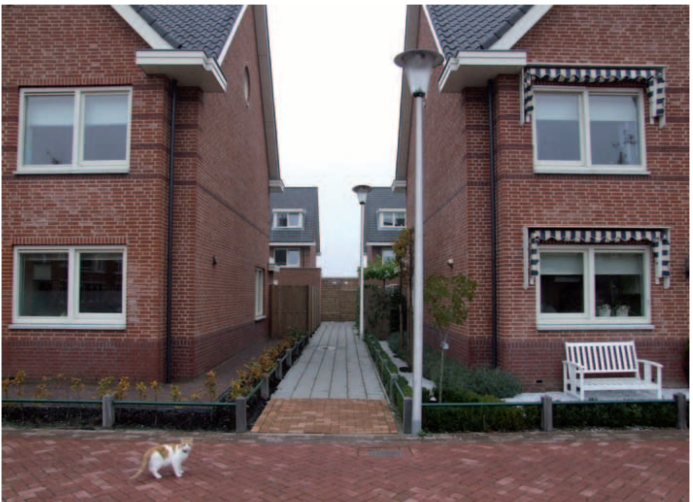
Openbare verlichting aan het begin van het achterpad heeft meerwaarde
